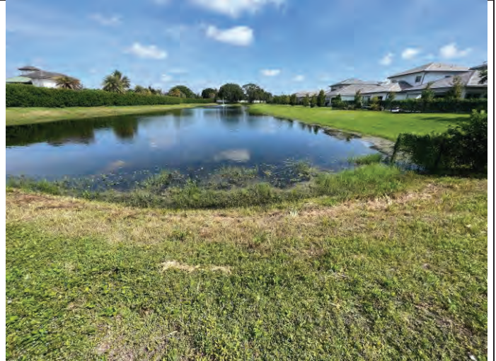
L-4 SE Embankment
