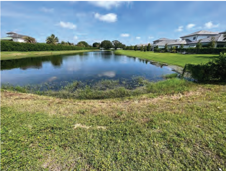
L-4 SE Embankment
