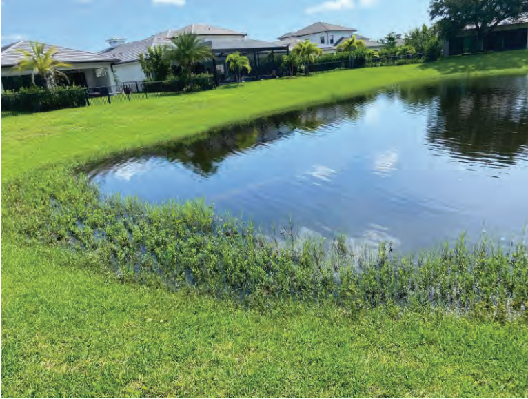
L-2 N Embankment
