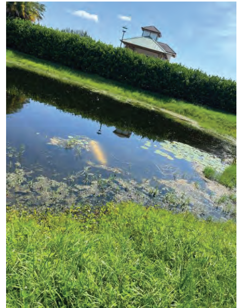
L-3 SE Embankment
