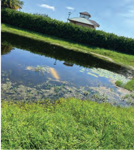
L-3 SE Embankment
